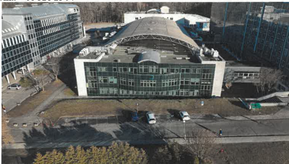
Fot. 1. Widok elewacji zachodniej
