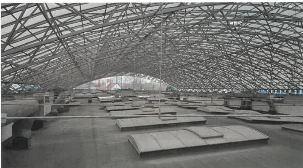
Fot. 5. Zadaszenie nawy środkowej – zabezpieczenie przed gromadzeniem się śniegu
