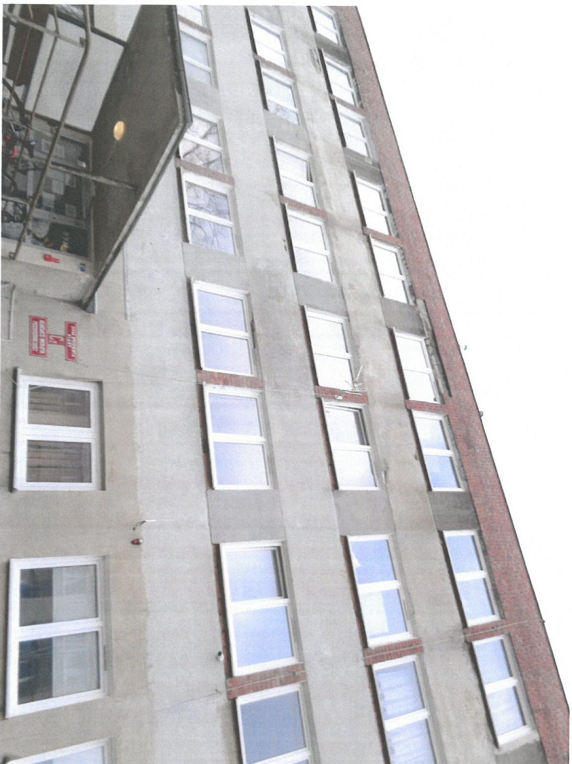
Elewacja zachodnia – widoczne ubytki płytek elewacyjnych i tynków.
