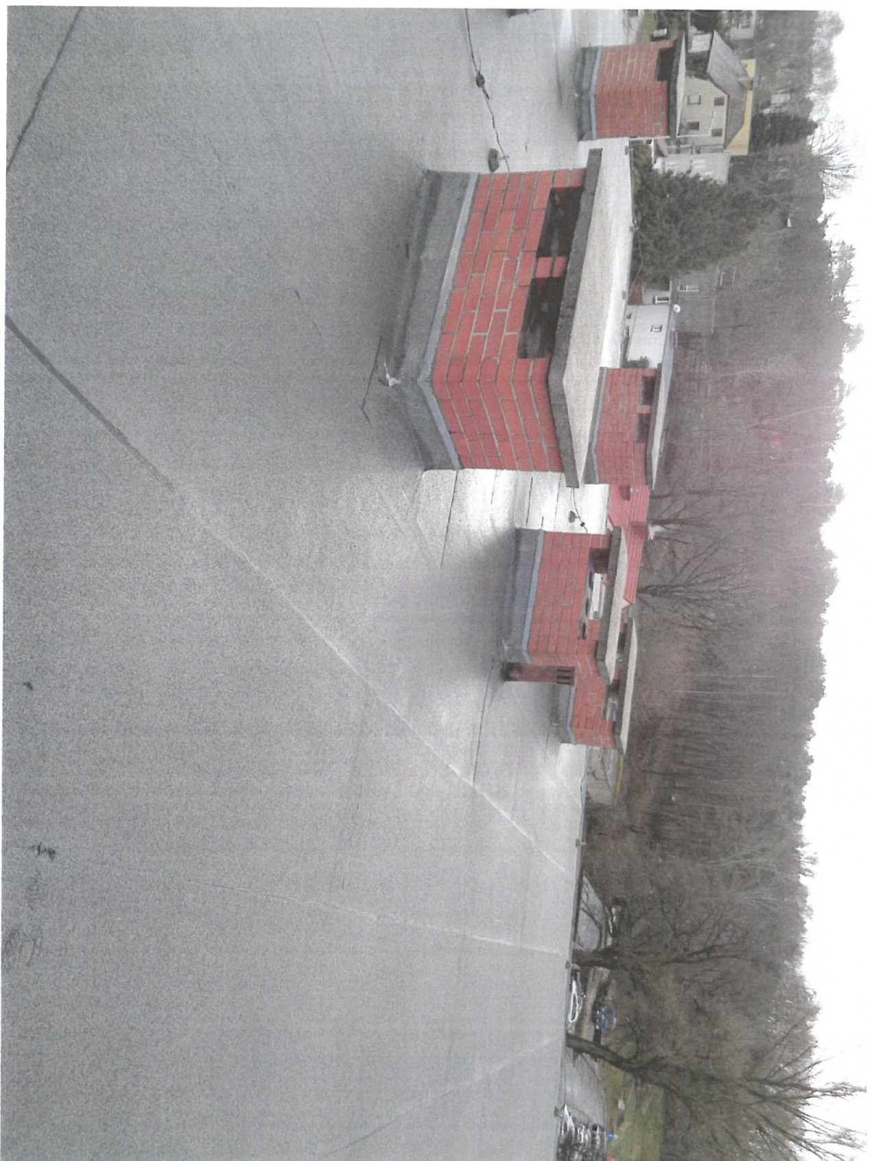
Dach widok w stronę południową – kominy do nadmnurowania, wywiewka do przedłużenia.
