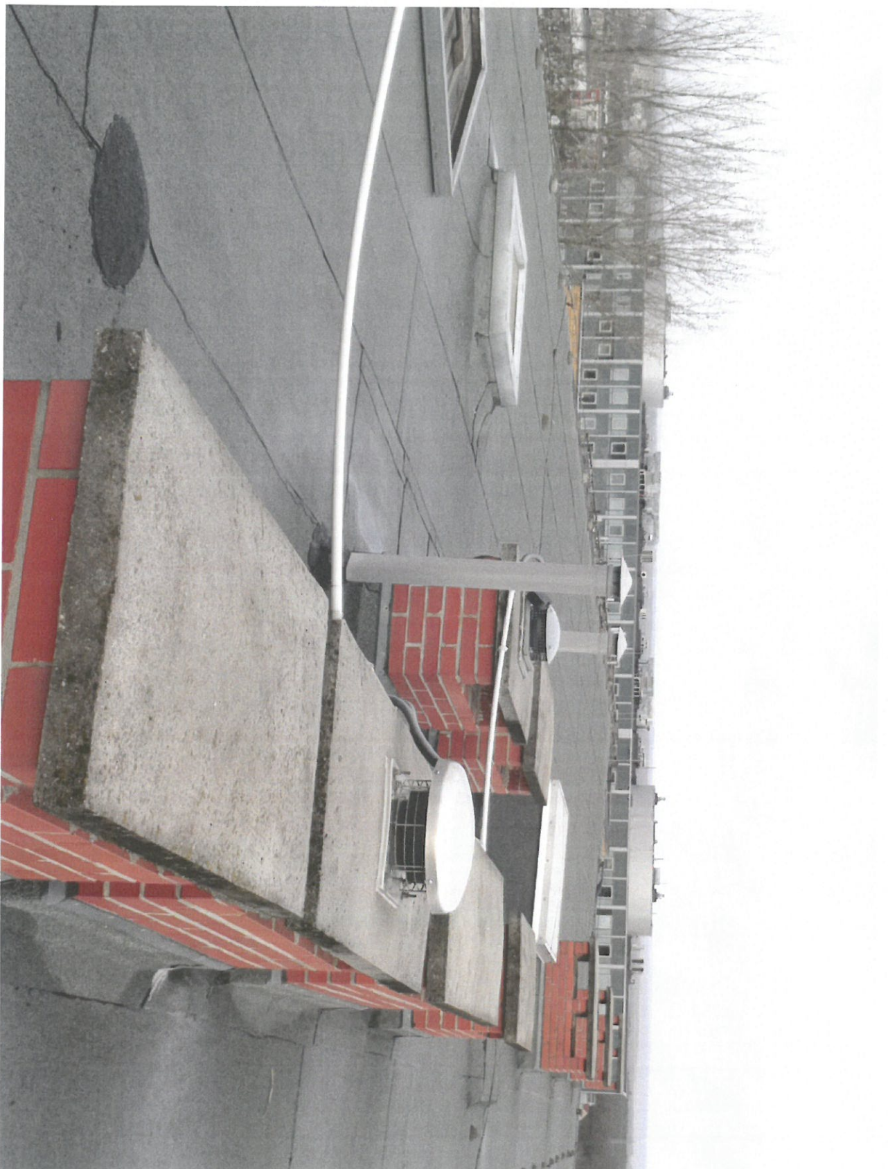
Dach – wyjazd dachowy do podniesienia.
