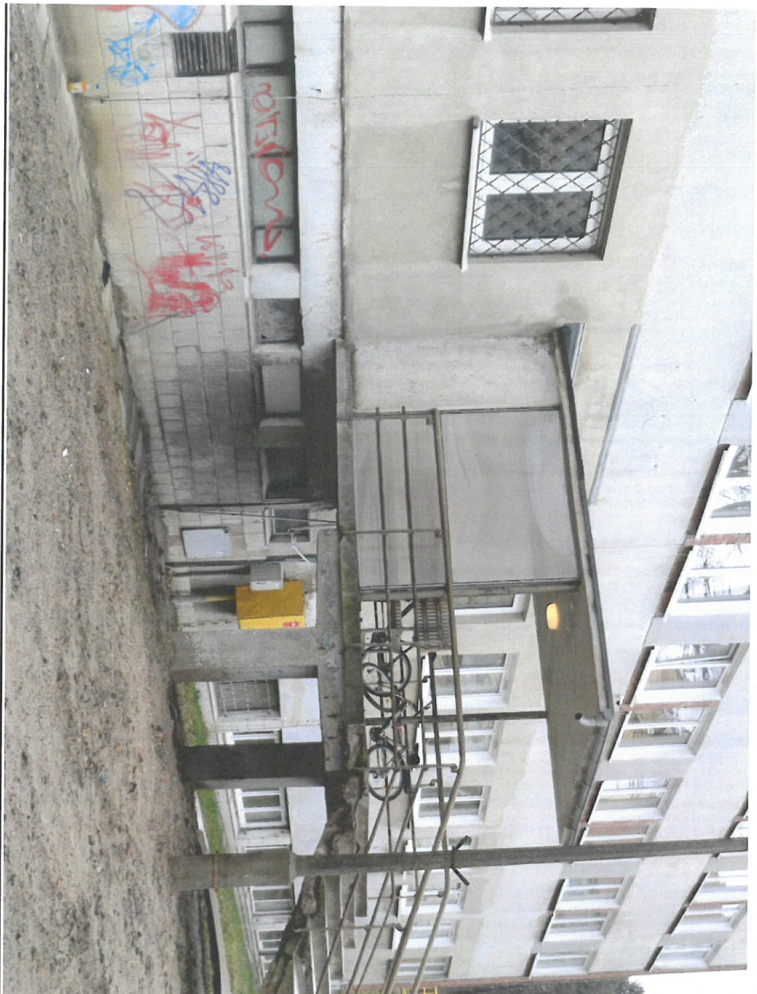
Zespół wejściowy do DS. „Piaś”. Widoczne uszkodzenia schodów i podestu.
