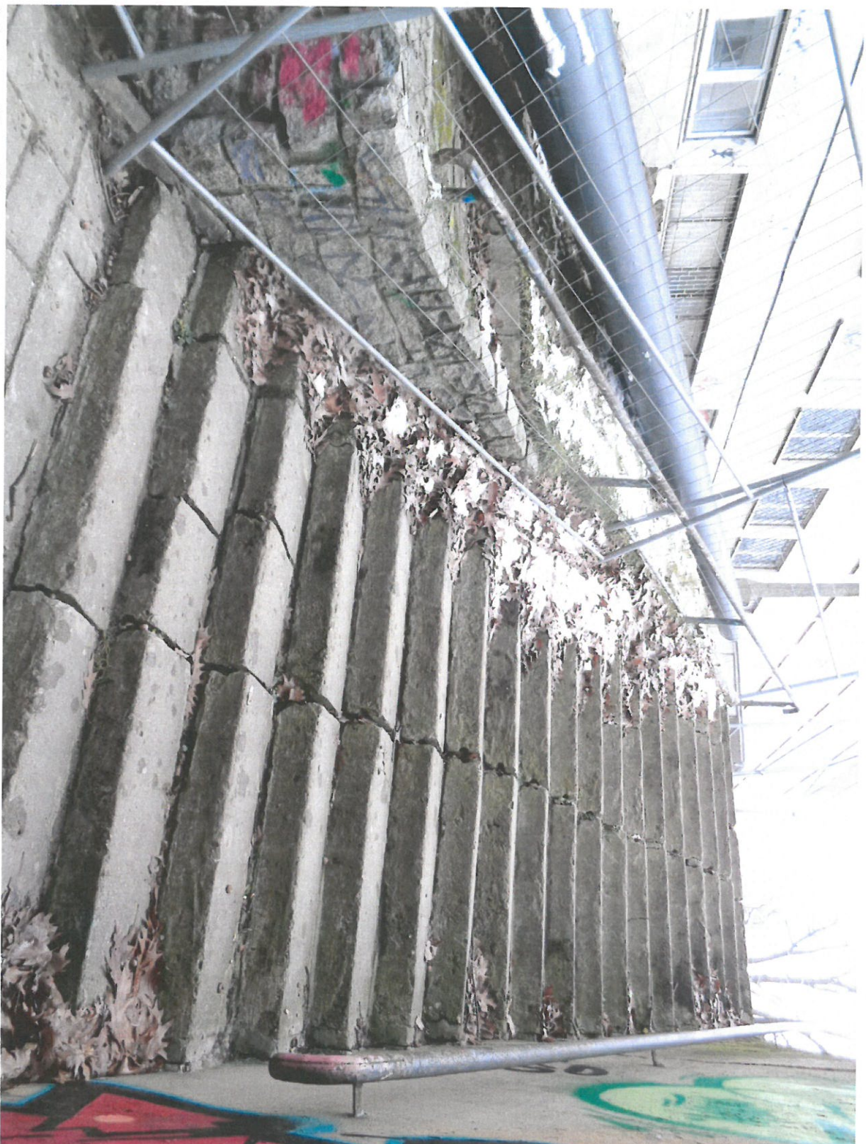
Schody pod łącznikiem i murek oporowy po lewej – do rozbiórki.
