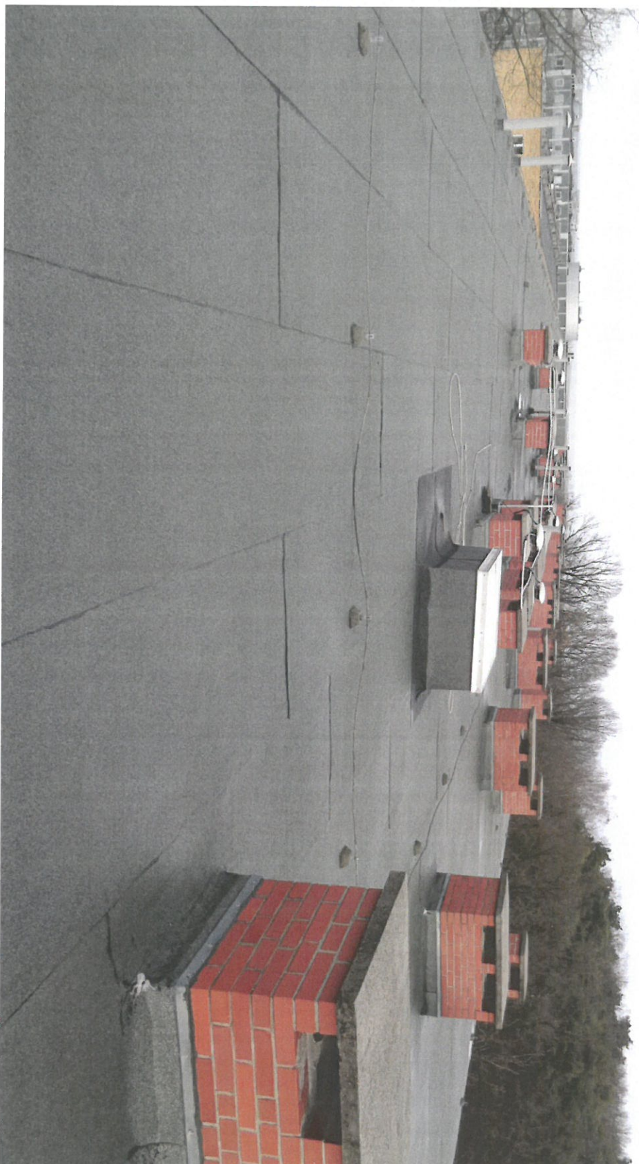
Dach widok w kierunku północnym – widoczne wentylatory do podniesienia po przemurowaniu kominów wraz z instalacją zasilającą.
