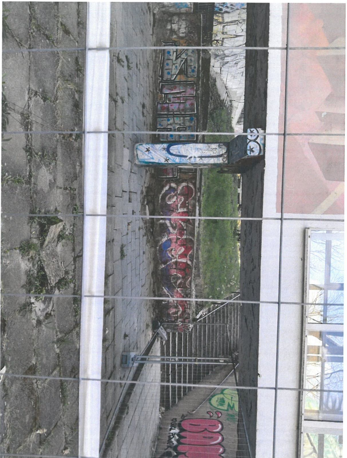
Do rozebrania: schody, murek oporowy z kamienia. Skarpa do splantowania. Studzienki za murem oporowym do przebudowy.
