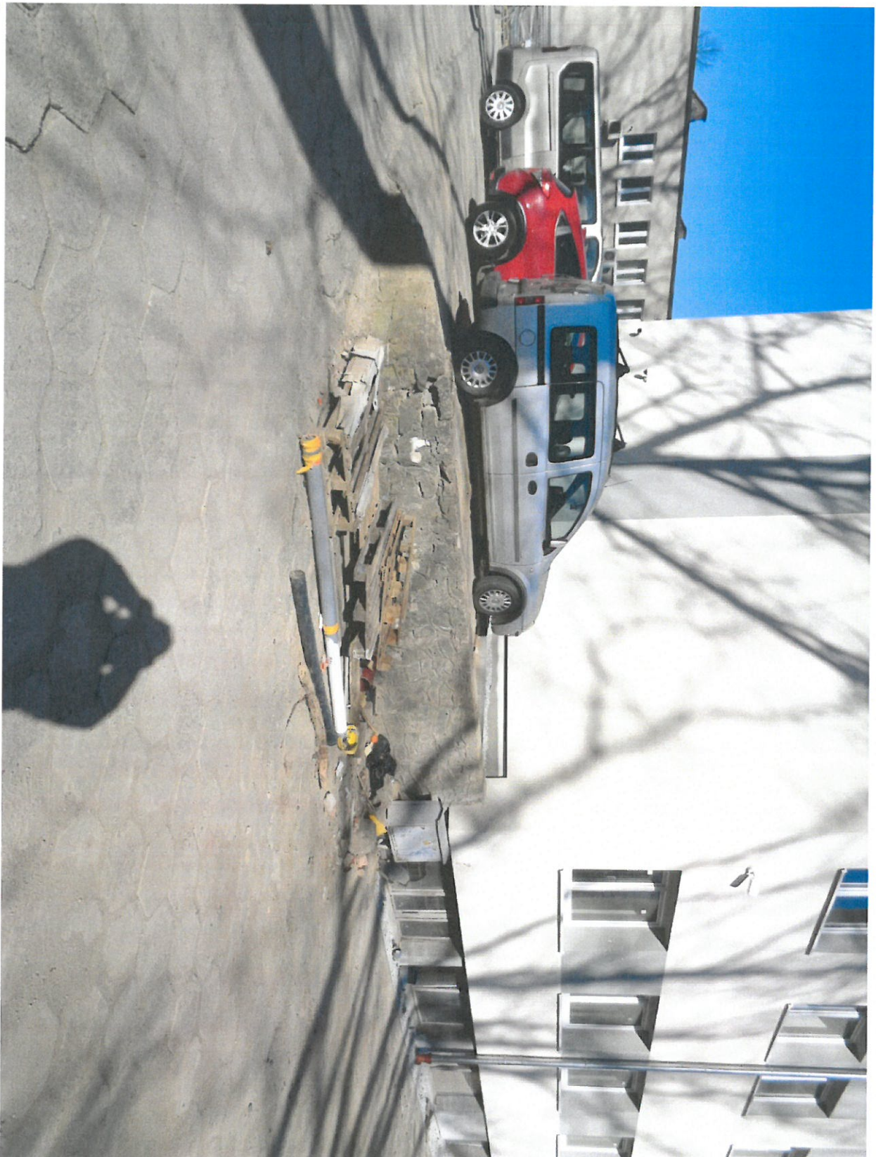
Droga pożarowa przy DŚ. „Rzepicha” – mur oporowy do rozbioru, teren za murem do przeprofilowania zgodnie z niwieletą drogi pożarowej.
