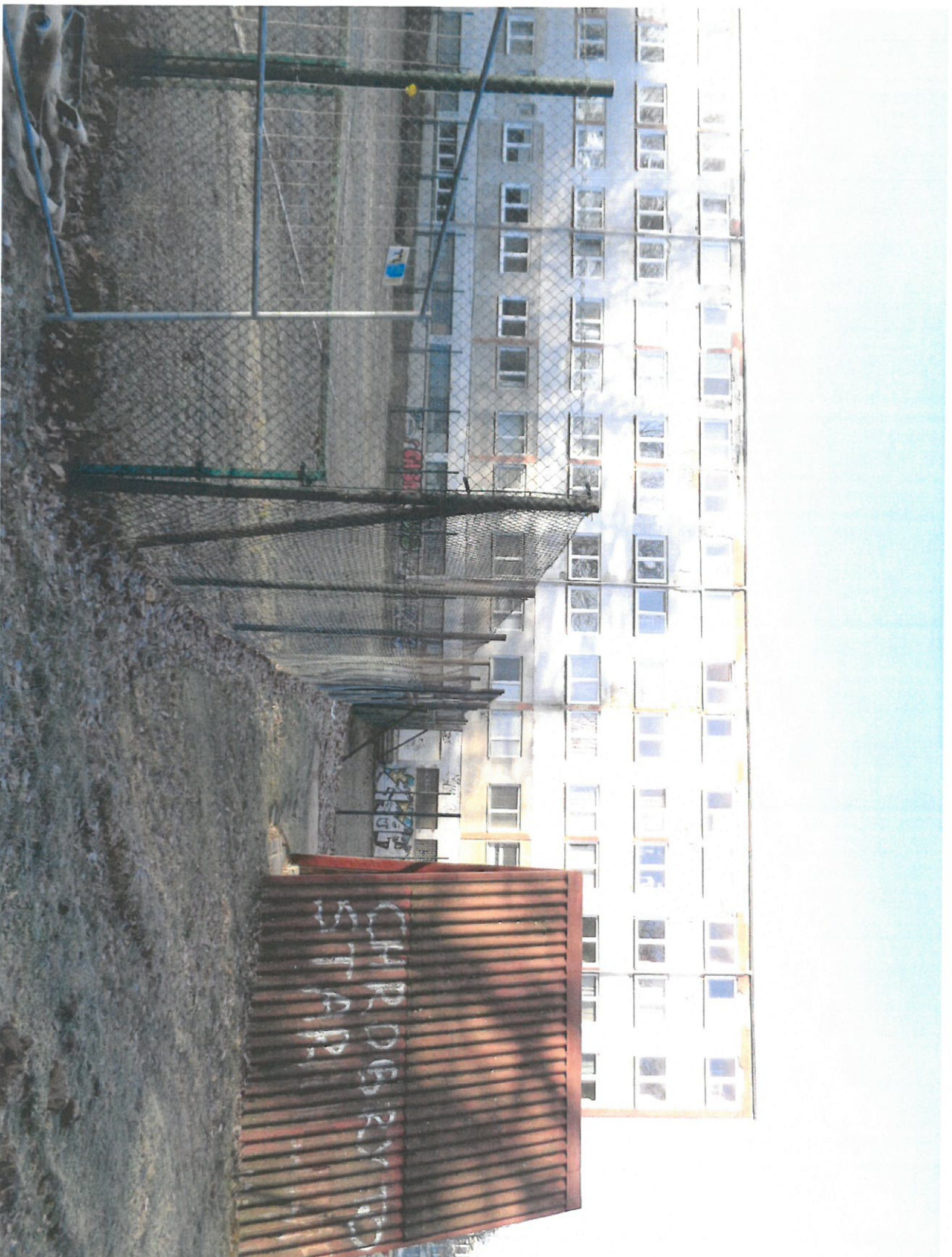
Elewacja wschodnia – liczne ubytki okładzin z płytek i tynków oraz gazobetonu.
