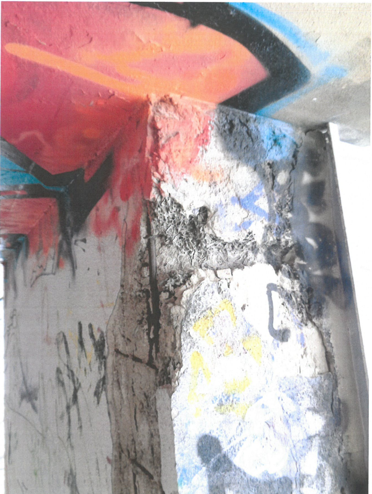
Uszkodzenia otuliny zbrojenia łącznika i izolacja z płyt wiórowo – cementowych do demontażu.
