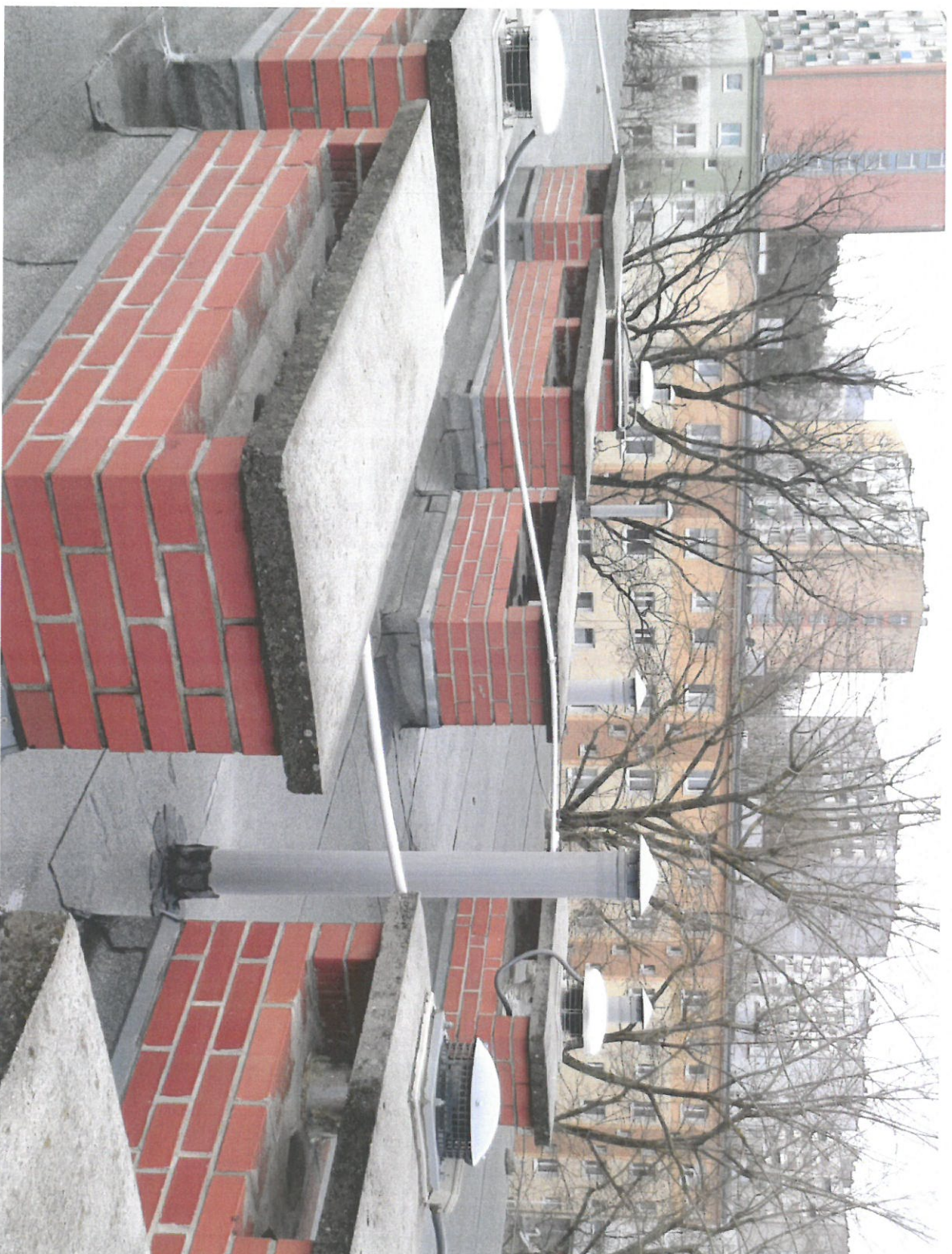
Wentylatory zamocowane do czapek kominowych do podniesienia wraz z czapkami i instalacją zasilającą po nadmurowaniu kominów. Blaszane kanały wentylatorów do przedłużenia.
