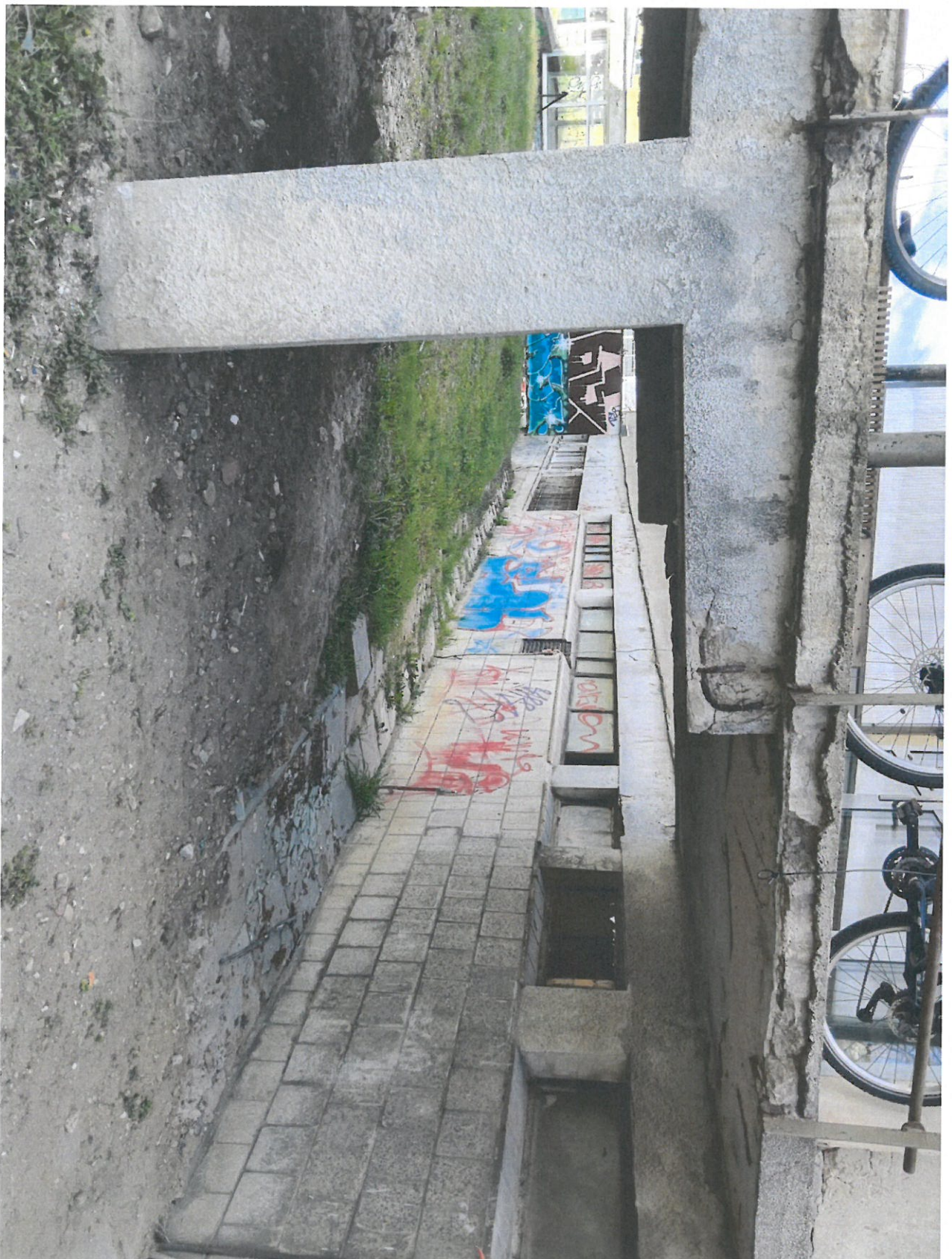
Ubityki otuliny zbrojenia podestu – do naprawy
