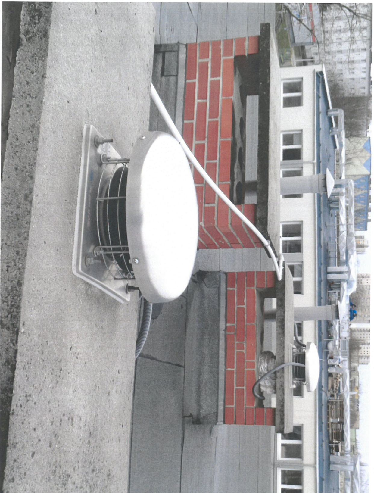
Wentylatory do podniesienia wraz z czapkami kominowymi, kanały wentylacyjne pod wentylatorami do przedłużenia.
